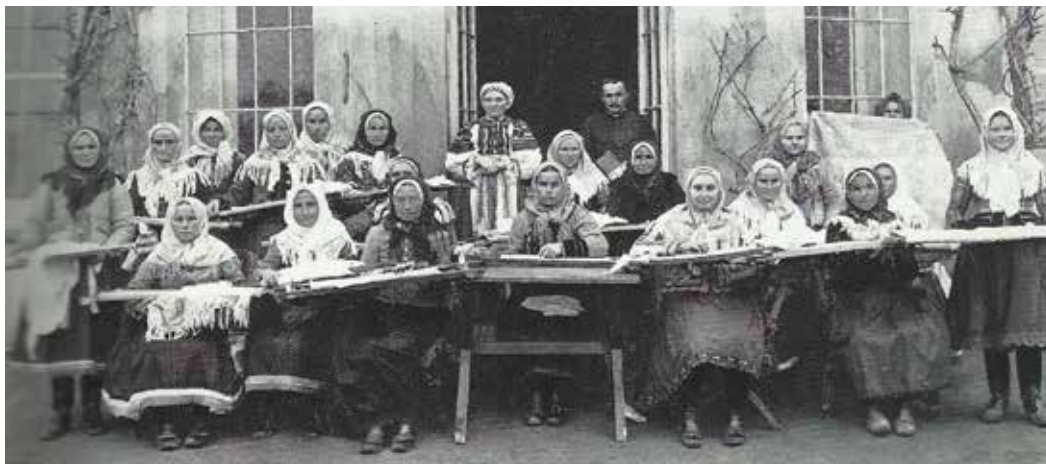
Obř. ř. 1: Vyšivačky pri práci v Cíferi v Zichyho kaštieli pod vedením vedúcej učiteľky Márie Hollósy. Fotografia pochádza z roku 1898 a fotila ju samotná arcikňažná Izabella.
