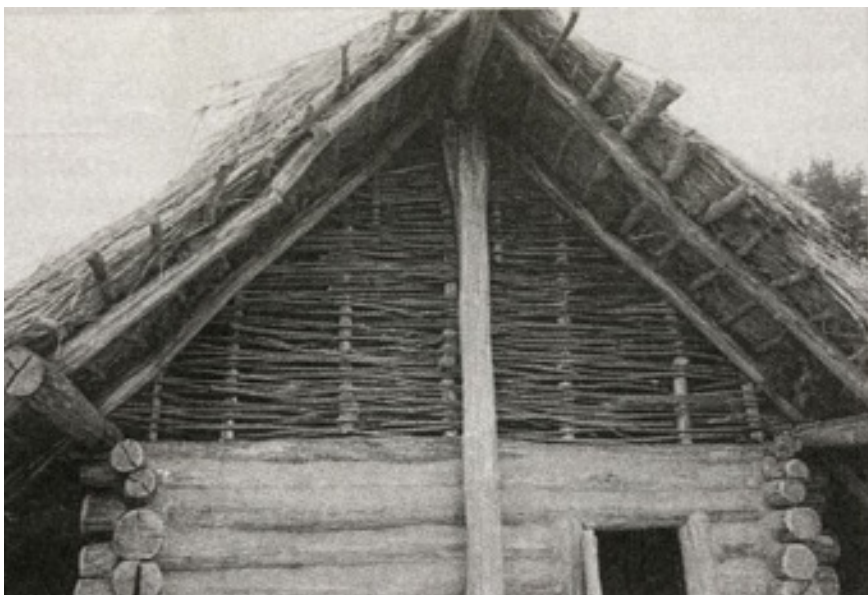
Obr. 26: Frontální část obydlí se stěnou stavěnou srubovou technikou, štítem vyplazeným proutím a s rákosovým pokryvem střechy, Archeoskanzen v Modré u Velehradu. (GALUŠKA, Luděk. Slované – doteky předků: O životě na Moravě 6.–10. století . Brno: Moravské zemské muzeum, 2004, s. 25.)
