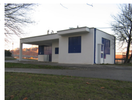
Obr. č. 74: Budova Propeleru
