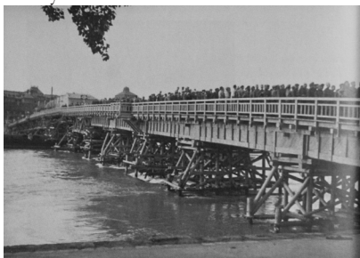
Obr. č. 48: Oproti kaviarni Leberfinger vybudovala Červená armáda drevený most
