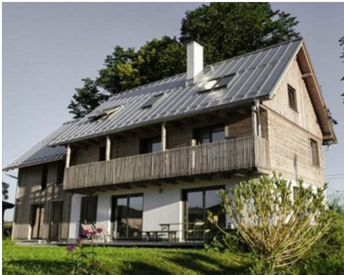
Obr. č. 8: Príklad novostavby inšpirovanej ľudovým stavitelstvom vychádzajúci zo slovenskej stavebnej tradície. Objekt je navyše bioklimatickou ekologickou stavbou. Blatnica, okr. Martin, 2012. Foto: M. Semal Kubinská.
