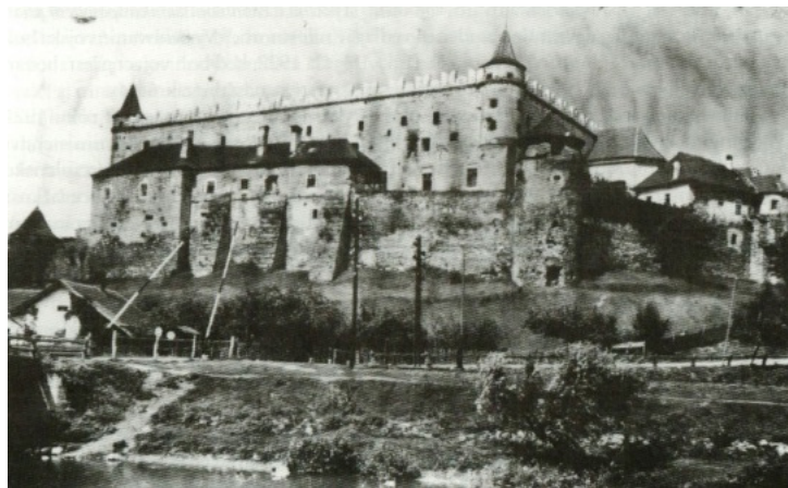
Obr. č. 3: Stav Zvolenského zámku v roku 1920. Zdroj: Archív PÚ SR.
